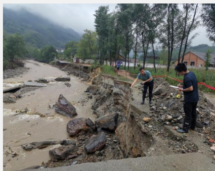
图 6-11 现场勘查水毁路段
