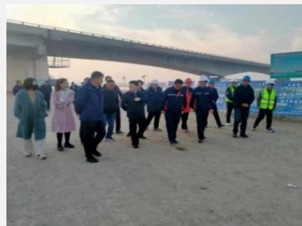
图 3-12 检查平罗黄河桥加固项目
