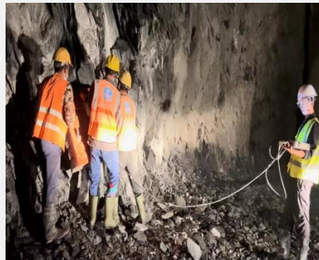
图 3-20 中尼项目地质探查施工现场
