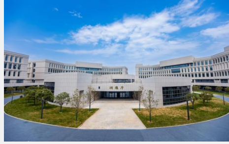
图 1-14 润德厅（学术报告厅）
